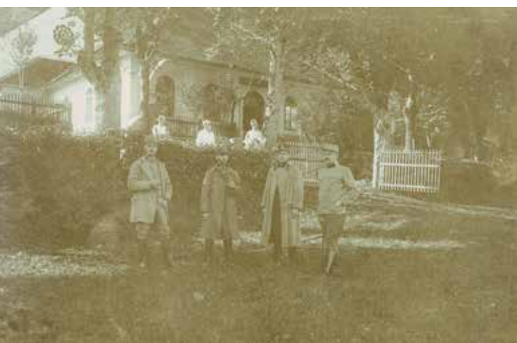
Izolirna bolnišnica za bolnike z nalezljivimi boleznimi v Vincarjih pri Škofji Loki.
