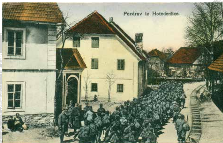
Razglednica ozkotirne železnice skozi Hotedršico. Promet po ozkotirni železnici od železniške postaje v Logatcu do Zadloga pri Črnem Vrhu je stekel 9. septembra 1916. Tire so povsod, kjer je bilo mogoče, polagali kar po obstoječi cesti ali poleg nje. ( http://www.kamra.si )
